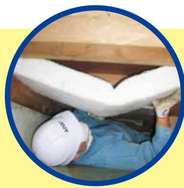
床下での断熱材設置作業のようす
